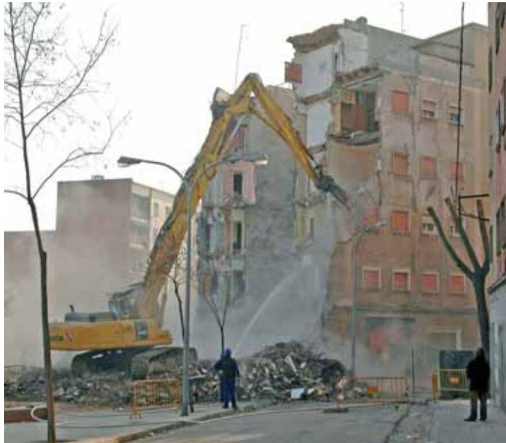
Després del moviment de terres va caldre enderrocar.
